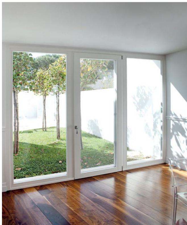
Negli infissi dei finestroni a tutta altezza, il vetro sarà sempre del tipo camera ma con la lastra esterna tipo "Visarm", spessore 6-7 mm, antiurto e di sicurezza, con elevata resistenza allo sfondamento.
