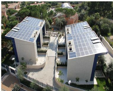
Residence le case blu è una struttura moderna e funzionale composta da otto mini ville, che ospitano nelle falde del tetto due impianti fotovoltaici da 20 KWh ciascuno, rendendo l'intera struttura energeticamente autosufficiente, con un esubero di produzione di energia elettrica che viene immessa sulla rete.
